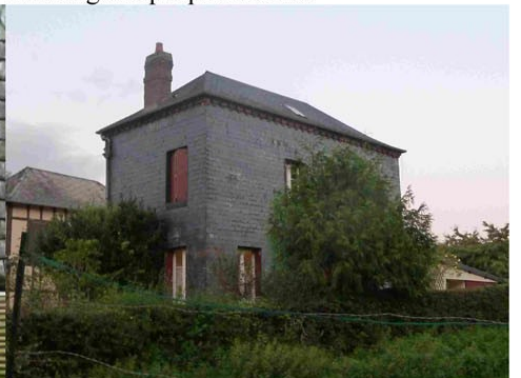
Essentage en ardoise revêtant complètement la construction
